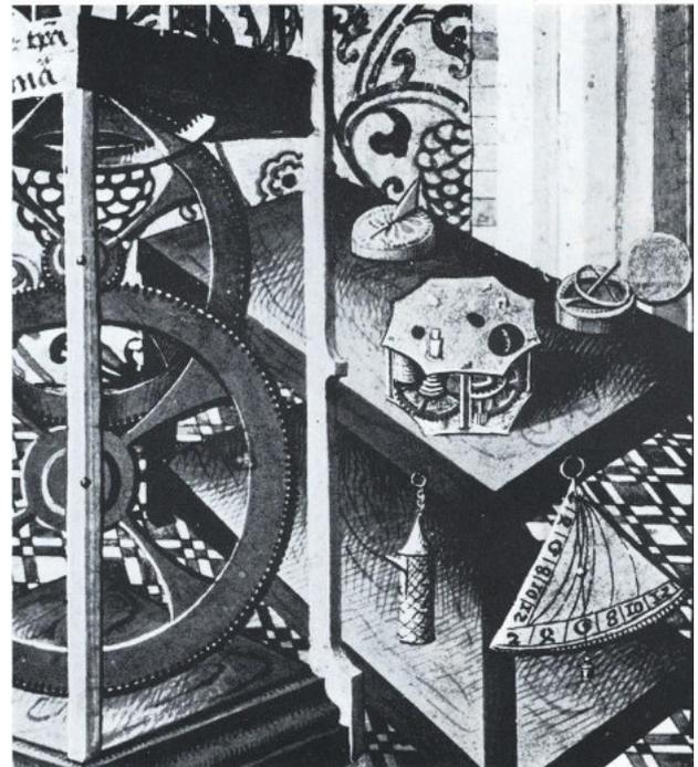
Il quadrante è stato rimosso e si vede il barileto con la corda avvolta, il conoide con l'asse di carica, il ruotismo con la ruota di scappamento, mentre il foro centrale è quello da cui è stata tolta la verga assieme al bilanciere. La miniatura è stata fatta poco prima del 1450.<sup>18</sup>
